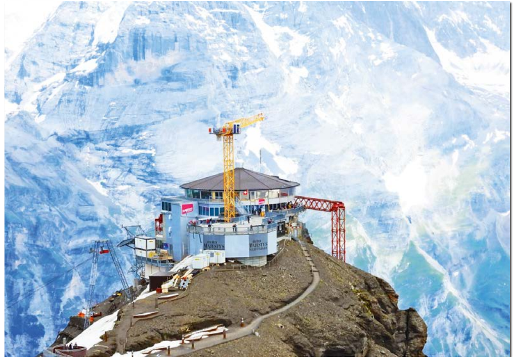
Grossbaustelle wegen der neuen SCHILTHORNBAHN 20XX auf dem Schilthorn. Fast alle beteiligten Firmen sind regional verankert.
